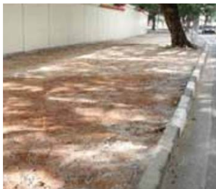
Figura 08 – Nivelamento e compactação do terreno
