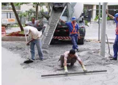
Figura 10 – Recebimento e espalhamento do concreto.
