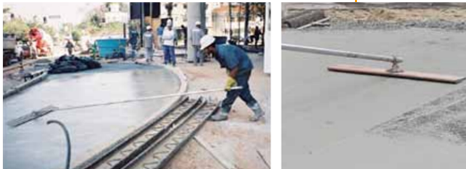
Figura 11 – Desempeno do concreto.
