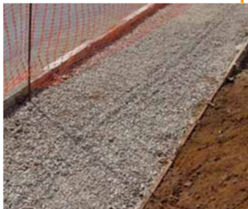
Figura 09 – Espalhamento da camada de Brita
